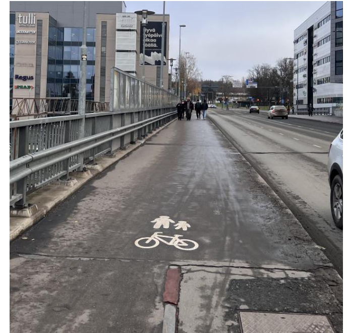
Kuva 35: Nykyinen yhdistetty pyörätie ja jalkakäytävä Sorinsillan pohjoislaidalla. Suunnitelmassa jalankulku ja pyöräily on eroteltu.
